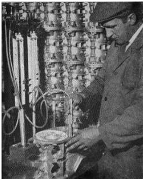
Solex-Meßgerät, hier beim Messen der Lagerbohrungen
