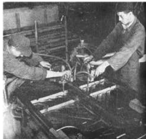
Das Teil des Bodenbleches, auf dem später die Sitze montiert werden, wird durch Querschienen verstärkt.
