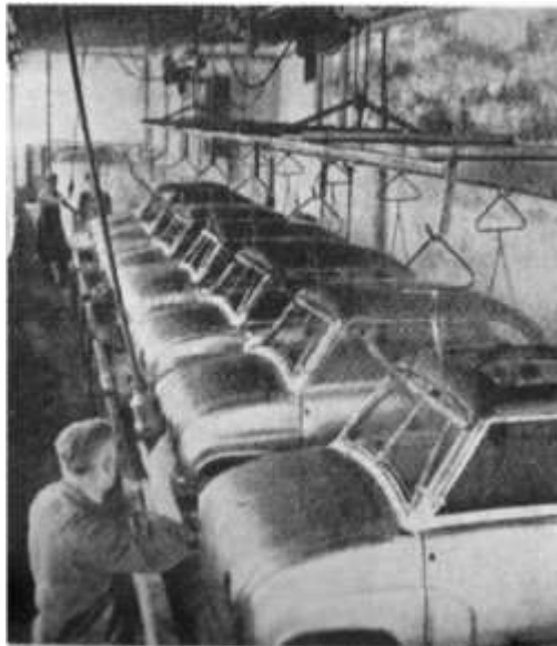
Chemisches Bad zur Schaffung einer metallisch reinen Oberfläche
