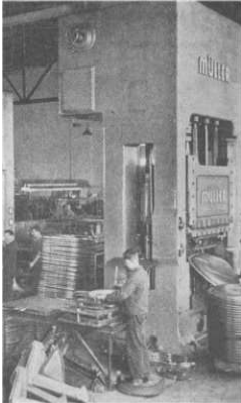
Eine der schweren Pressen, in diesem Fall eine 400-Tonnen-Tiefzieh-Pressse
