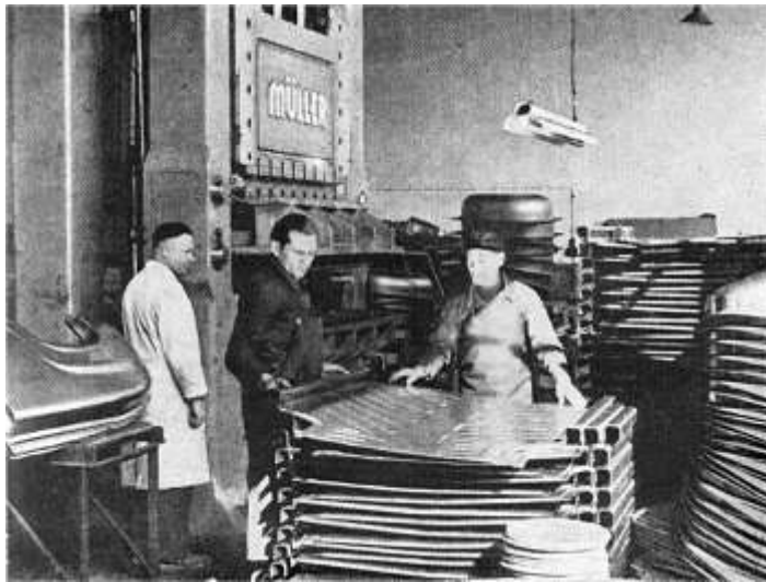
Das größere Formstück kommt aus der 400-t-Ziehpresse und wird sofort zur weiteren Bearbeitung in die große Montagehalle transportiert.
